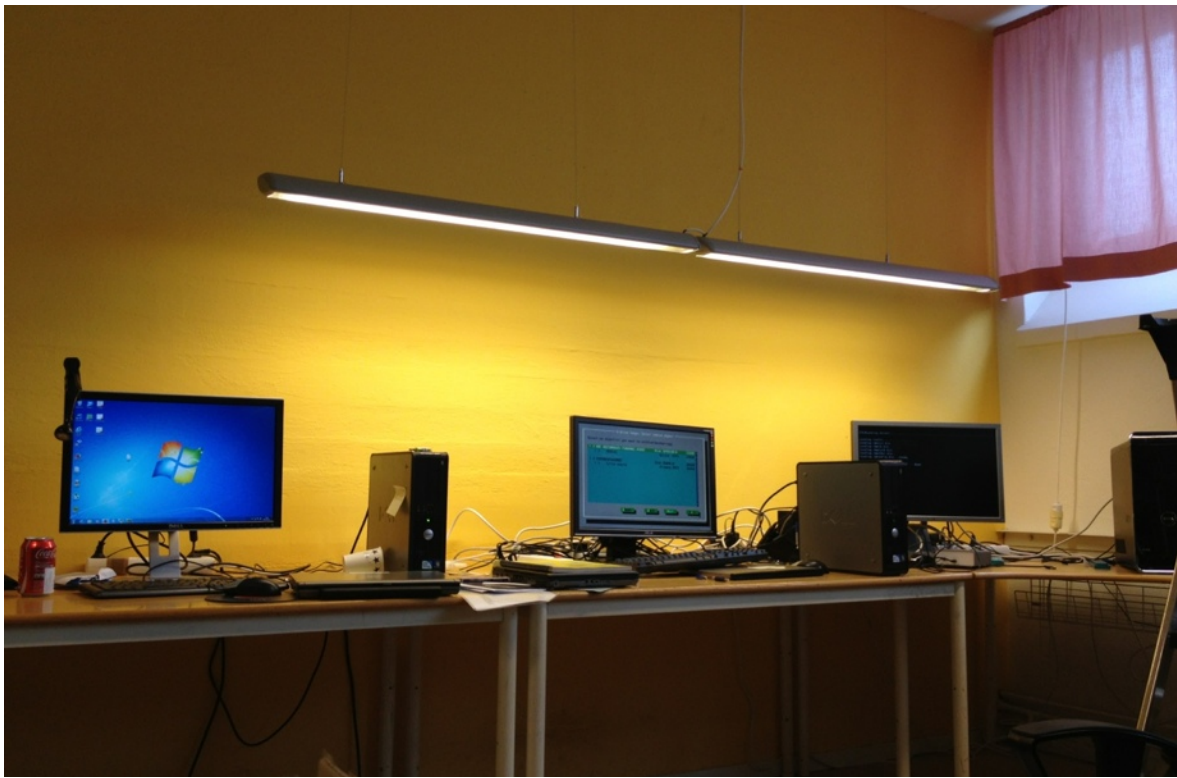
Uppföljning efter fem månader - komplettering av lysrörsramp. Pär har nu fullgott ljus över alla arbetsstationer.
